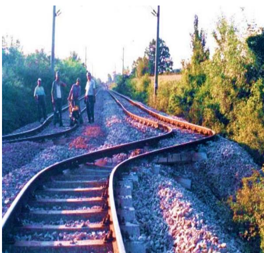
Μετατόπιση τουλάχιστον 2 μέτρα της σιδηροδρομικής τροχιάς μετά το σεισμό του 1999 (Ιζμίτ) στην Τουρκία σε τμήμα του ρήγματος οριζόντιας ολίσθησης της Βόρειας Ανατολίας.
