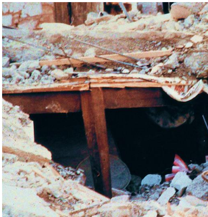
Τραπέζι που δημιουργεί έναν θύλακα με αέρα που μπορεί να οδηγήσει στην επιβίωση ανθρώπου μετά την πτώση κτιρίου
